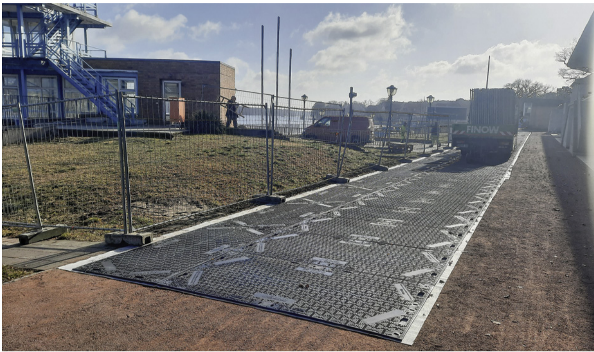
Bauvorbereitung an der Regattastrecke
