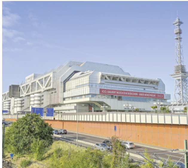
Das ICC am Funkturm vor einer neuen Zukunft Foto: IMAGO/Joko
